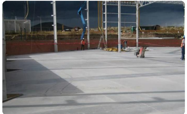
Industriële vloer – OC Puma-fabriek, Mexico. 10 kg/m 3 Anti-CRAK® HP 67/36 + 0,6 kg/m 3 Anti-CRAK® HD12, C 25/30.
