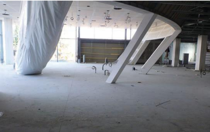
Bedrijfsvloer – Audi dealer, Frankrijk. 5 kg/m 3 Anti-CRAK® HP 67/36 + 0,6 kg/m 3 Anti-CRAK® HD12, C 20/25.
