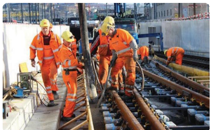
Bielzen spoorlijn – Zurich Diameter Line, Zwitserland. 8 kg/m 3 Anti-CRAK® HP 67/36, C 25/30
